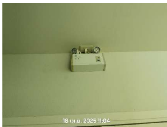
รูปที่ 2.41 เครื่องสำรองไฟฉุกเฉิน
