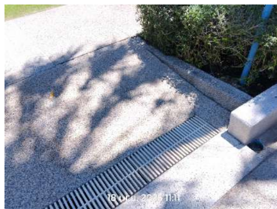
รูปที่ 2.32 รางระบายน้ำล้นมีฝาปิดรอบสระว่ายน้ำ
